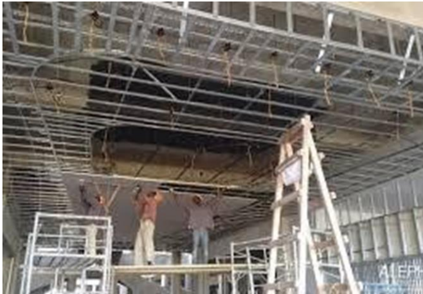
Ilustración 21: Fijación del panel
